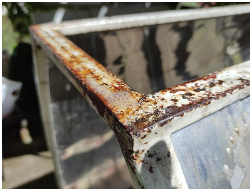
Figura 2.5. Estructura metálica del CPC 2
